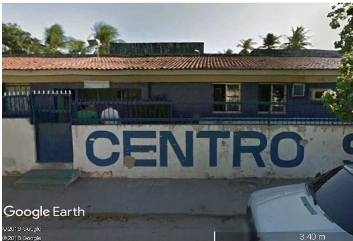
Figura 1 – Entrada principal de acesso para pedestres em CS1
